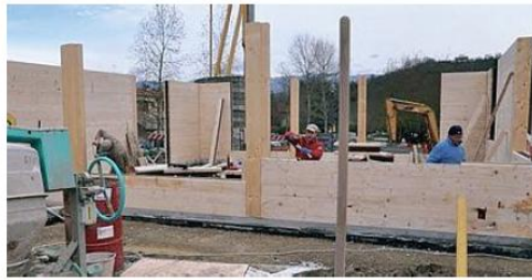
In corso la posa delle pareti in legno all'asilo «Girandola»
